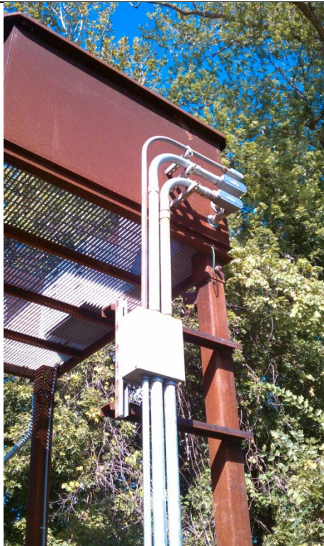
Pump Power & Monitor Conduits
